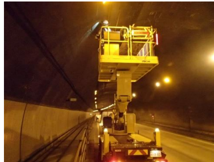
トンネル点検状況
