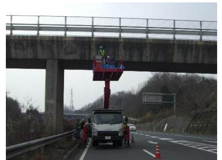
高架橋点検状況
