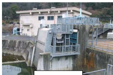
川南排水機場
