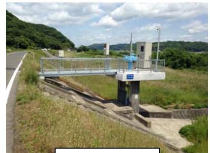
三光寺排水樋門
