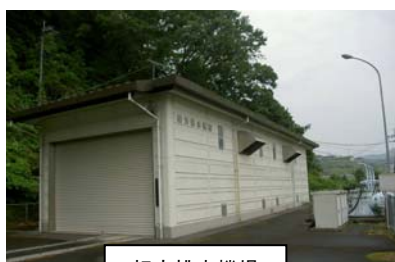
相方排水機場
