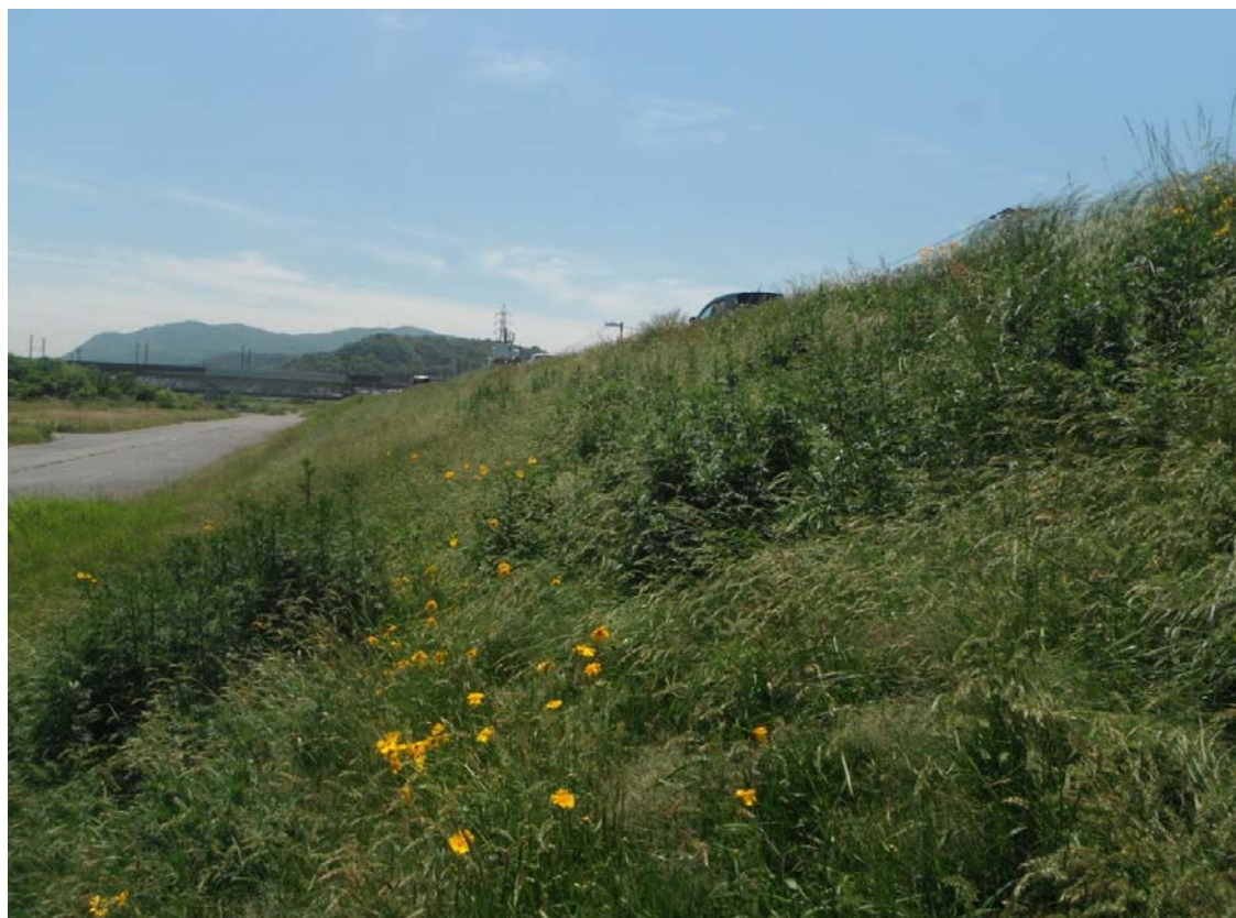
芦田川右岸9K200付近 H28. 5. 18撮影(試験施工後)
