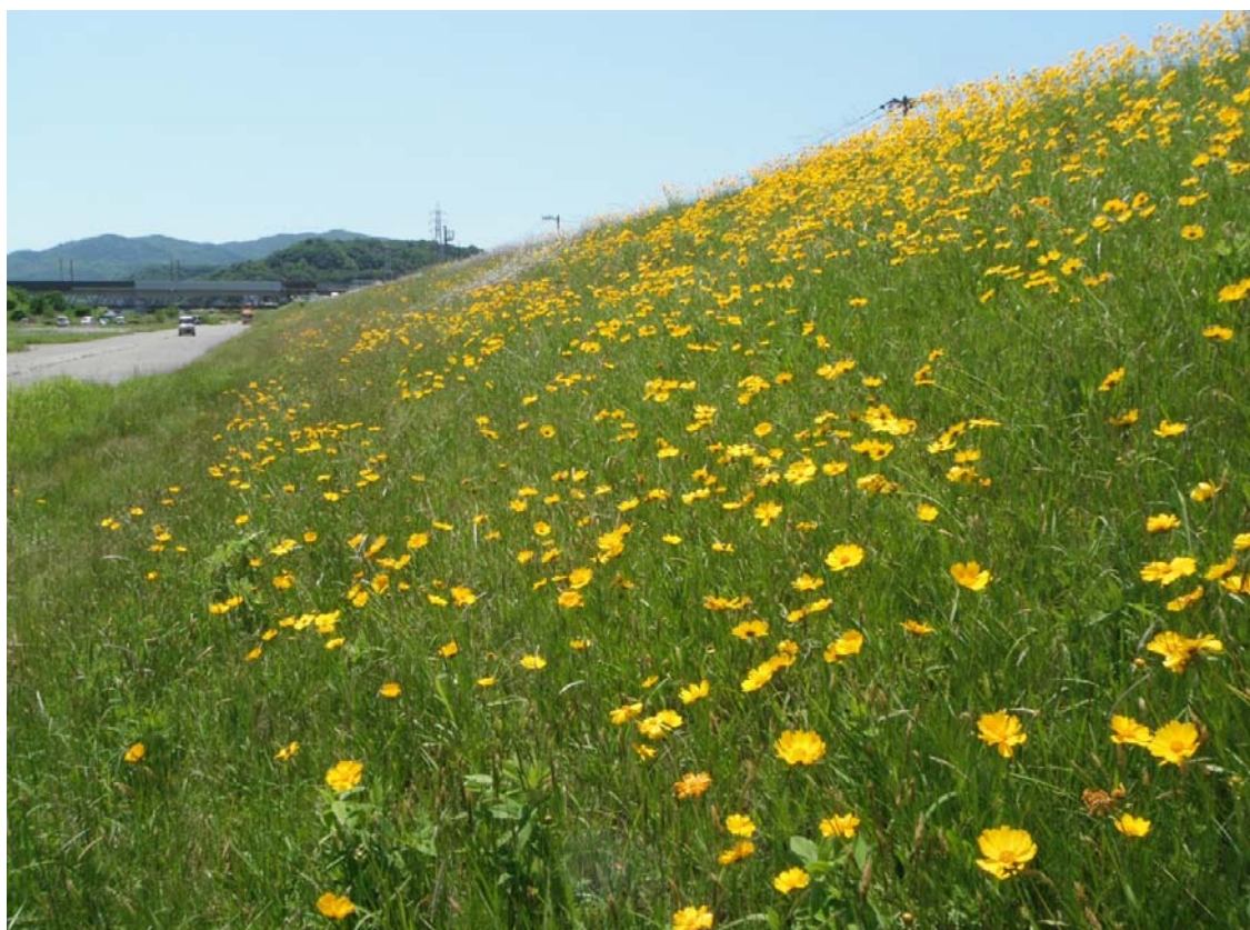
芦田川右岸9K200付近 H27. 5. 21撮影(試験施工前)
