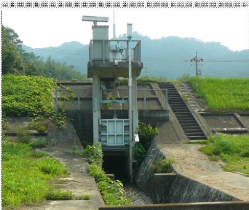
芦田川の排水樋門
