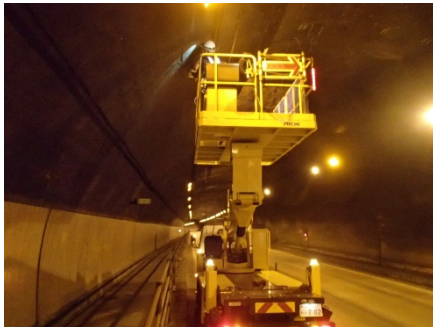
トンネル点検状況
