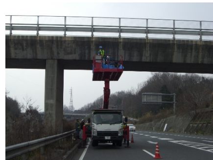
橋梁点検状況
