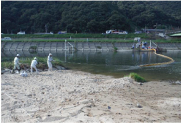
オイルフェンス展張訓練
