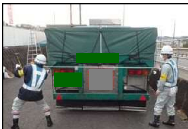
車両幅計測状況（R2.12）下り
