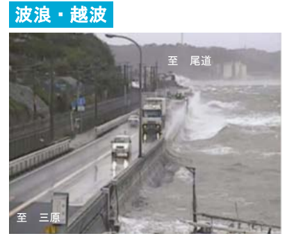
特殊通行規制区間が存在し、災害時には通行止めの可能性があり、道路が脆弱
