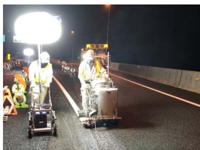
区画線塗装状況
