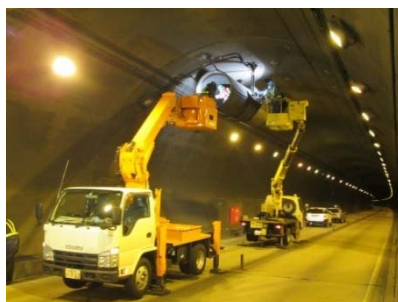
ジェットファン点検状況
