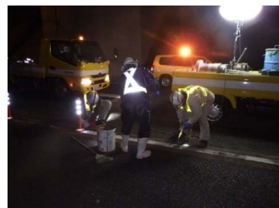
安全施設の更新状況
