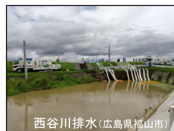
令和2年7月出水時の支援状況
