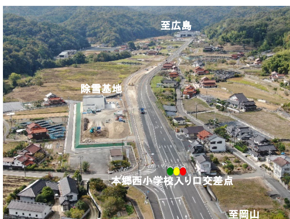
（仮称）本郷除雪基地整備状況
