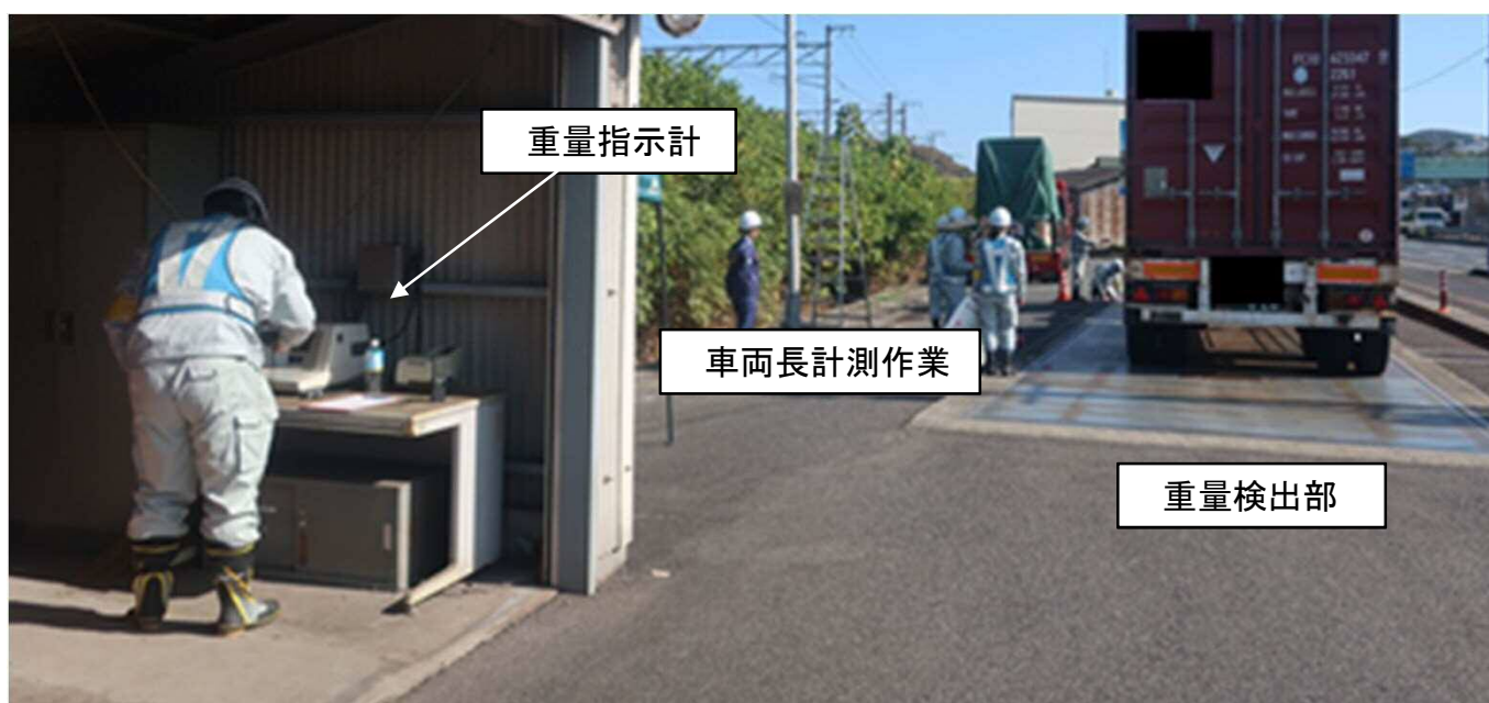
車両重量計測 及び 車両長計測
