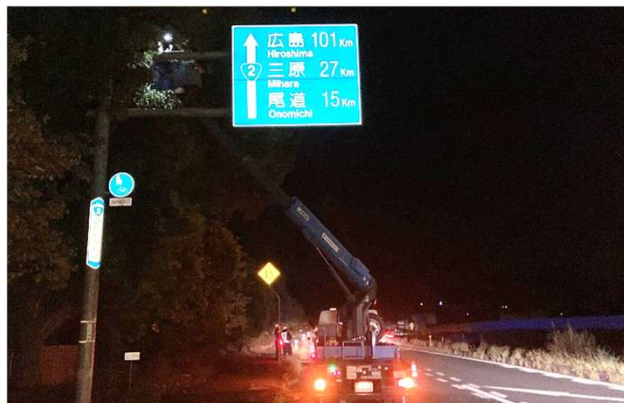
標識点検作業イメージ
