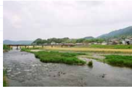
25.2km付近の中州とヨシ等の繁茂(早瀬の連続が見られる)
