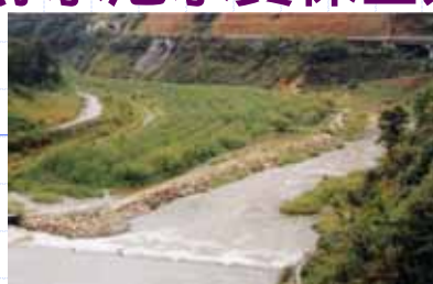
植生浄化施設
