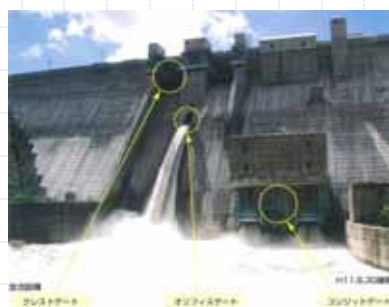
八田原ダムの放流施設
