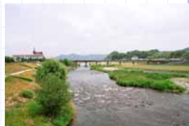
早瀬の連続する河道 (府中新橋付近)
