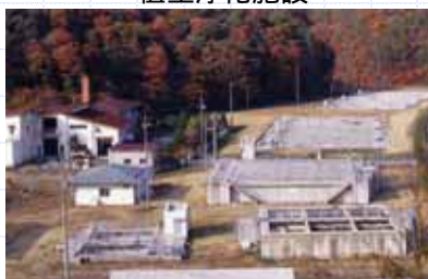
接触酸化+土壌浄化施設
