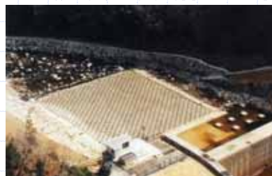
礫間接触酸化施設
