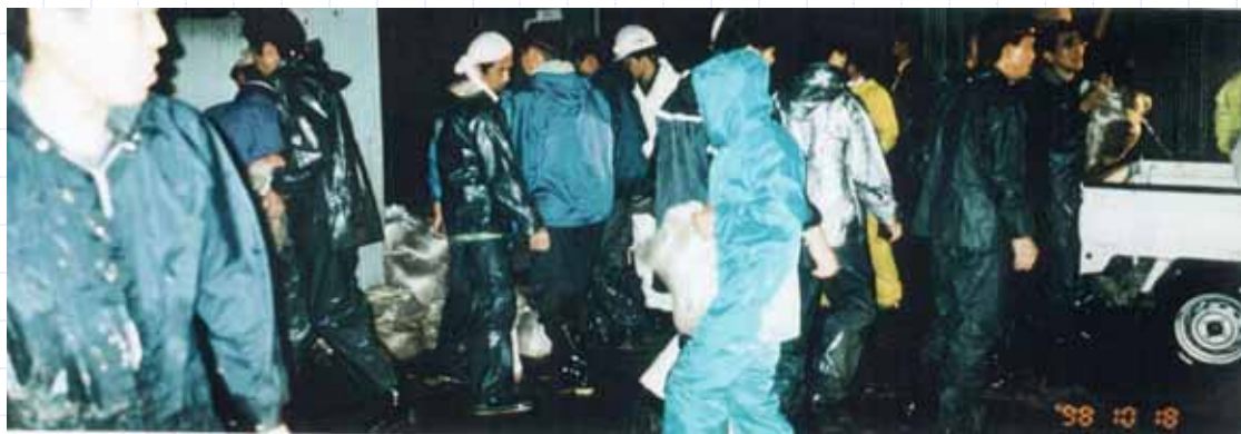
水防活動状況(土のう敷設作業)
