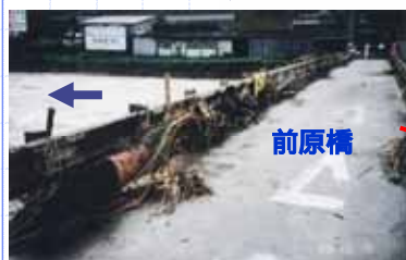
前原橋の越水状況
