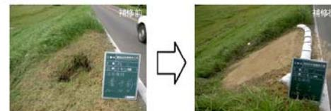
写真 5-2-8 堤防の補修状況
