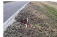
写真 2-3-1 堤防の陥没
