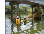
写真 5-2-15 潜水ポンプに付着したゴミの除去
