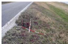
写真 2-3-1 堤防の陥没
