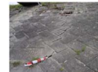
写真 2-3-2 老朽化による護岸のクラック
