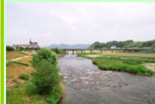
早瀬の連続する河道 (府中新橋付近)
