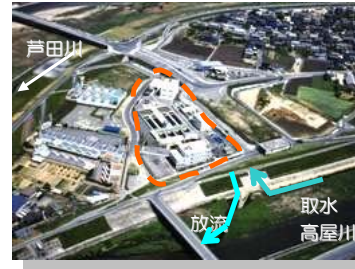
高屋川河川浄化施設で高屋川の流水を浄化
