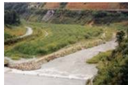
植生浄化施設
