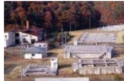
接触酸化+土壌浄化施設
