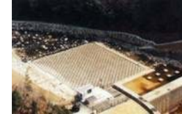
礫間接触酸化施設
