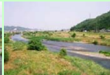
樹木などの繁茂 (中須大橋付近)
