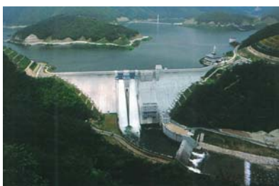
写真 1-2-4 八田原ダム（平成 10 年 3 月完成）
