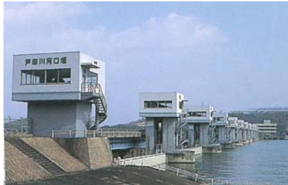
写真 1-2-3 芦田川河口堰（昭和 56 年 6 月完成）
