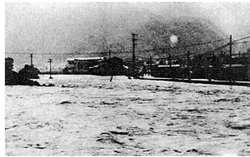
府中市府中町の浸水状況
