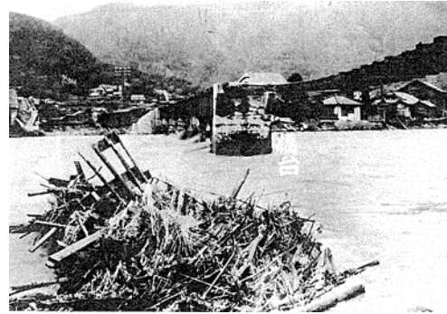
府中市父石町の浸水状況
