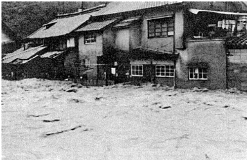
芦品郡新市町の浸水状況
