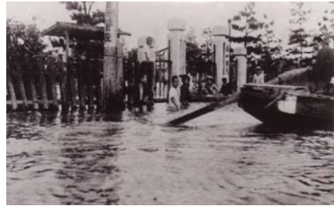
南小学校前の浸水状況
