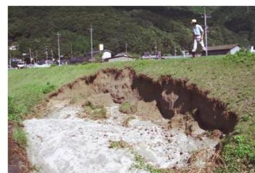
写真 2-3-10 洪水による堤防の損傷
