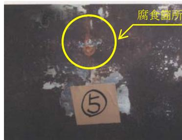
写真 2-3-5 放流管の劣化状況
