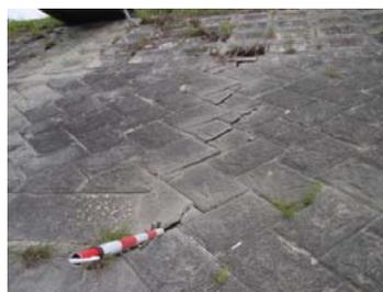
写真 2-3-2 老朽化による護岸のクラック
