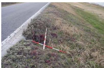
写真 2-3-1 堤防の陥没
