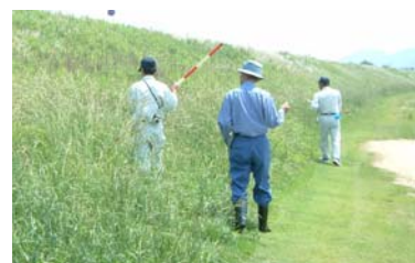
写真 5-2-2 堤防の点検状況
