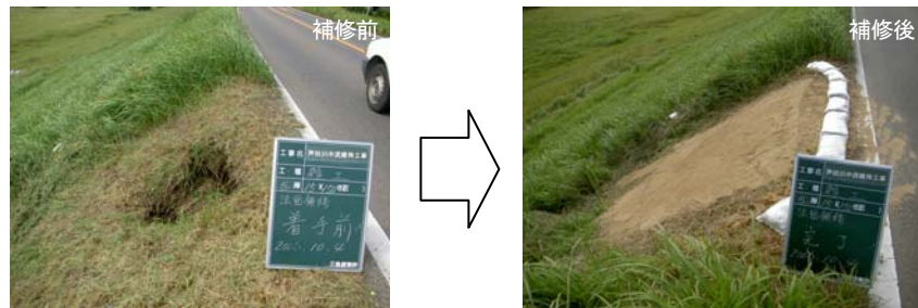
写真 5-2-8 堤防の補修状況
