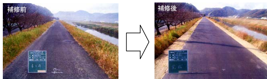
写真 5-2-9 堤防天端（上面）の補修状況
