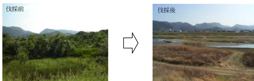
図 5-2-13 河道内樹木の伐採状況（18k200 付近）
