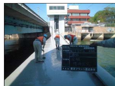
写真 5-2-18 ゲート管理・点検
