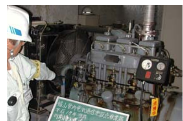
写真 5-2-3 排水ポンプ場の点検状況
