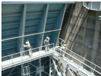
写真 5-2-16 クレストゲートの点検状況
