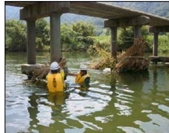
写真 5-2-15 潜水橋に付着したゴミの除去
