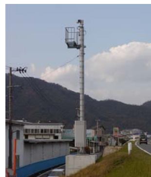
写真 5-2-11 CCTV の設置状況
