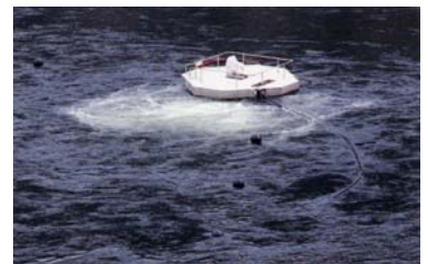
写真 5-1-10 躍層低下循環施設
