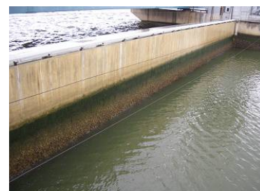
写真 2-3-6 主ゲートの劣化状況
