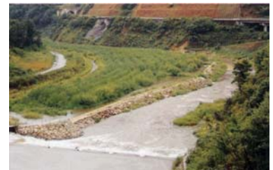
写真 5-1-9 植生浄化施設
