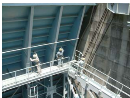
写真 5-2-16 クレストゲートの点検状況
