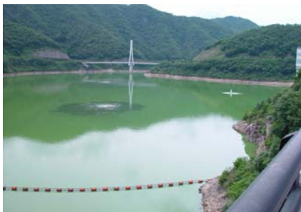
写真 2-2-35 アオコの発生状況 (八田原ダム)
