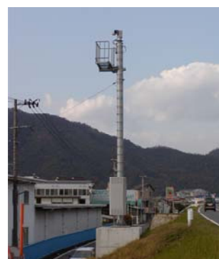
写真 5-2-11 CCTV の設置状況
