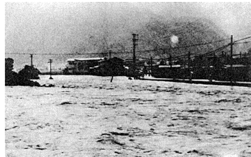
府中市府中町の浸水状況
