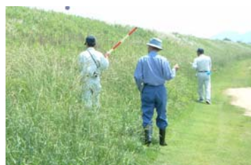
写真 5-2-2 堤防の点検状況
