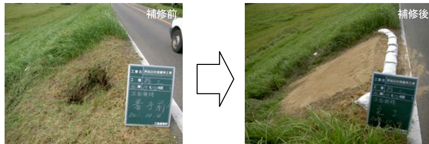
写真 5-2-8 堤防の補修状況
