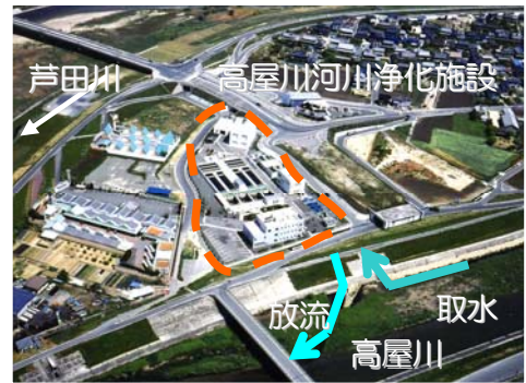
写真 5-1-8 高屋川河川浄化施設
