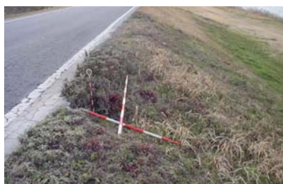
写真 2-3-1 堤防の陥没
