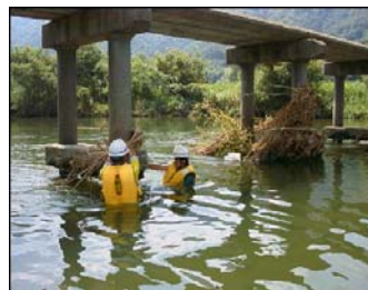
写真 5-2-15 潜水橋に付着したゴミの除去
