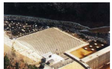
写真 5-1-11 礫間接触酸化施設
