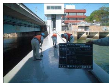
写真 5-2-18 ゲート管理・点検
