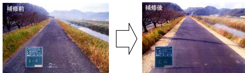
写真 5-2-9 堤防天端（上面）の補修状況
