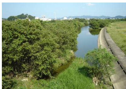
写真 2-3-3 河道内樹木の繁茂
