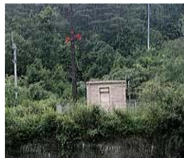
写真 5-2-17 八田原ダム放流警報設備
