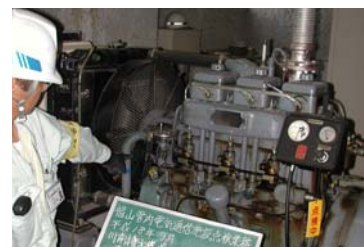
写真 5-2-3 排水ポンプ場の点検状況
