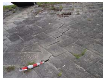
写真 2-3-2 老朽化による護岸のクラック
