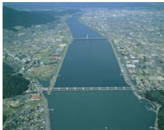
写真 2-2-24 芦田川河口堰と湛水区間
