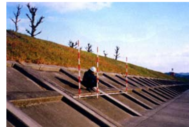
写真 5-2-5 洪水痕跡調査
