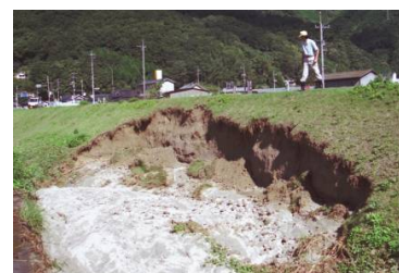
写真 2-3-10 洪水による堤防の損傷
