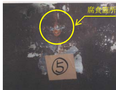
写真 2-3-5 放流管の劣化状況
