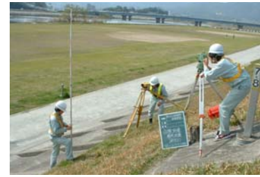
写真 5-2-4 縦横断面測量
