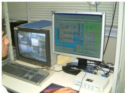
写真 5-2-29 排・取水門の遠隔操作状況
