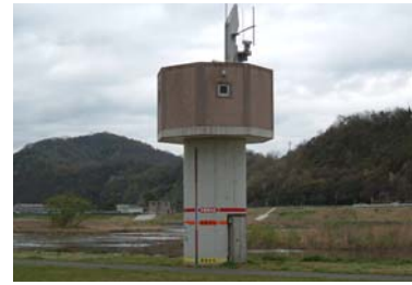
写真 5-2-31 水位観測所への水位表示 (山手水位流量観測所)
