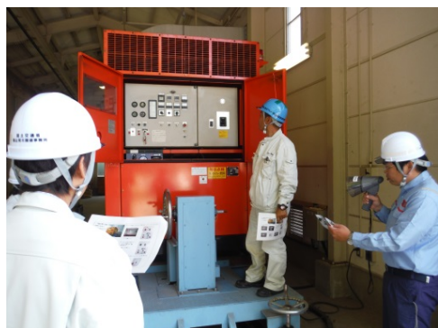
排水機場操作訓練
