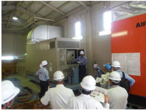
排水機場操作訓練
