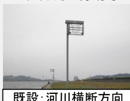
既設: 河川横断方向 堤防側
