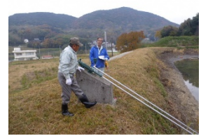
ため池の現地パトロール
