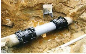
漏水防止のための整備
