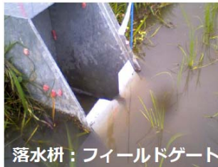
流出を抑制する排水堰板の例
