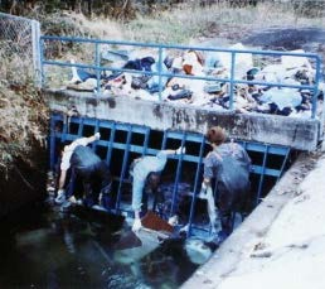
除塵機への廃棄物流入
