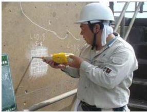
老朽化した施設の機能診断
