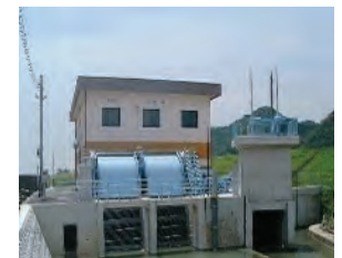
排水機場の整備
