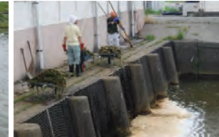
スクリーンの除塵作業
