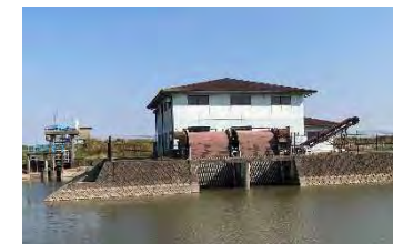
(排水機場整備)
