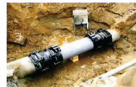
漏水防止のための整備
