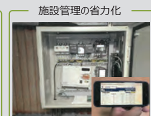
監視装置の設置
