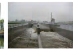
(排水分水ゲート)
