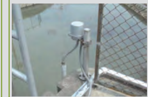
水位計の設置
