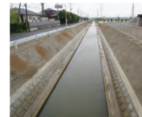
排水路の整備
