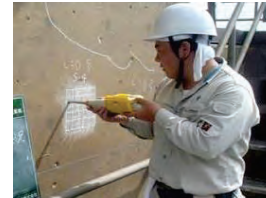
老朽化した施設の機能診断
