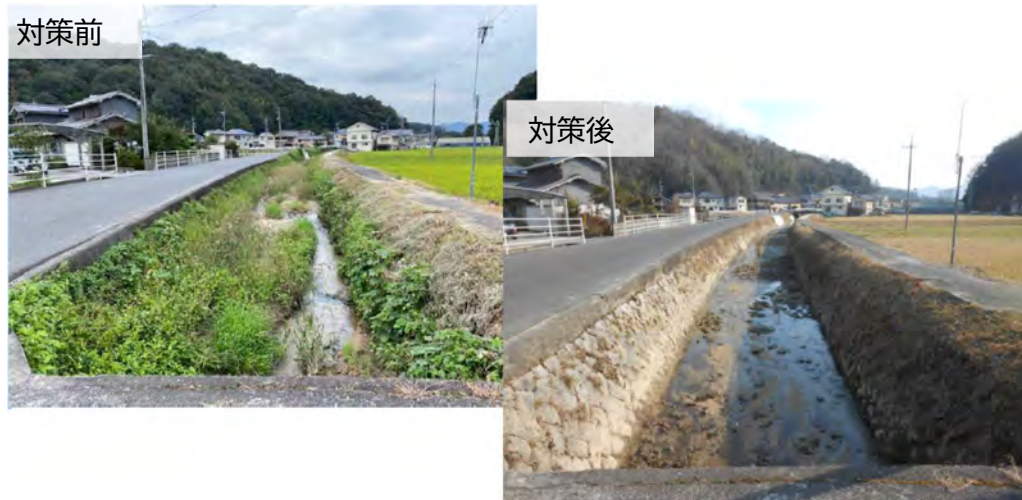
河道掘削（服部川水系助元川）
