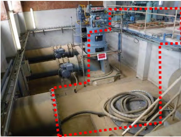
古市排水ポンプ場3号ポンプ増設（天王前川）
