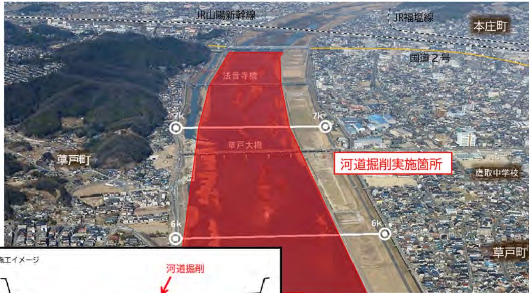
河道掘削（福山市草戸・水呑地区）
