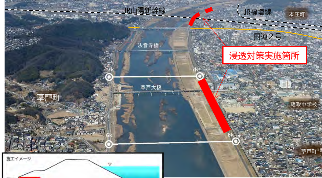
堤防浸透対策（福山市草戸・本庄地区）
