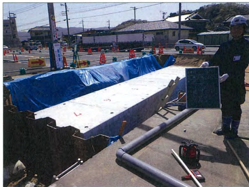
水路改修（出水1号雨水幹線）
