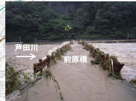
平成30年7月豪雨 床上浸水754戸(福山市・府中市 内水被害含む)
