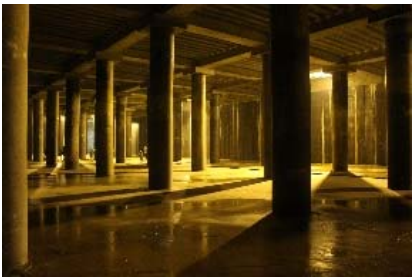
大規模地下貯留施設(下水道)
