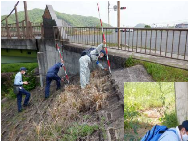
◀ 徒歩による点検で、堤防に異常が無いが確認
