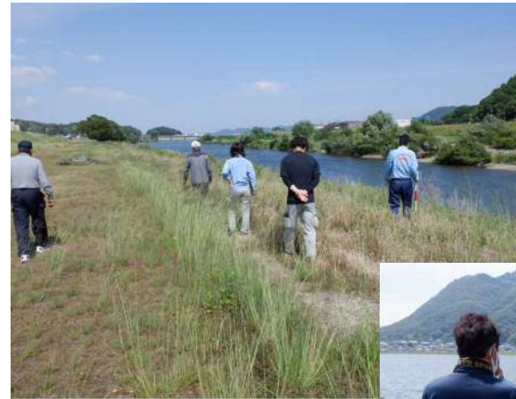
◀ 施設利用者の方々と共に護岸を点検しました。
