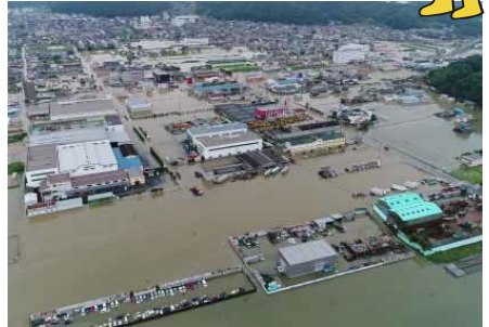
平成30年7月豪雨時の浸水状況 (福山市神辺町)
