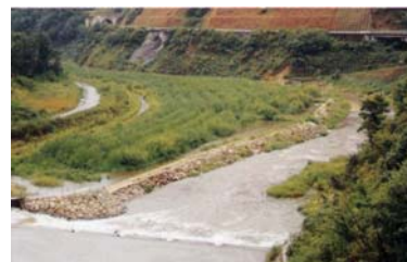
写真 5-1-9 植生浄化施設
