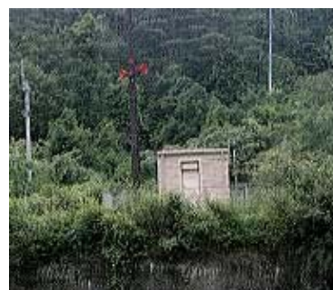
写真 5-2-17 八田原ダム放流警報設備
