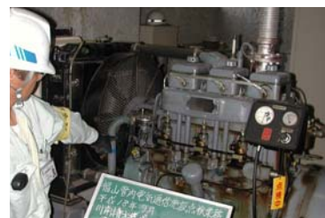
写真 5-2-3 排水ポンプ場の点検状況
