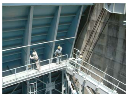
写真 5-2-16 クレストゲートの点検状況
