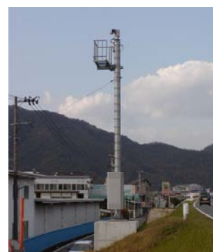
写真 5-2-11 CCTV の設置状況
