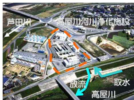
写真 5-1-8 高屋川河川浄化施設
