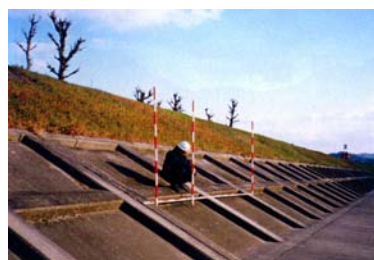
写真 5-2-5 洪水痕跡調査
