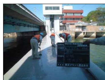
写真 5-2-18 ゲート管理・点検
