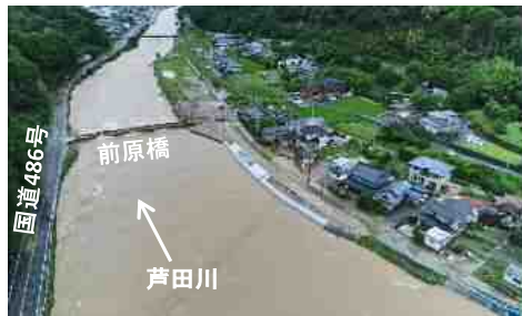
平成30年7月豪雨による出水状況 (府中市父石町付近)
