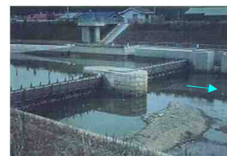
高屋川河川改修着手(H7～H11早田堰改築)
