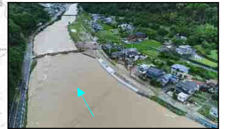
府中市父石町付近の浸水状況
