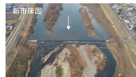
魚道のない横断構造物の例
