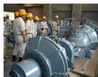
排水機場操作訓練
