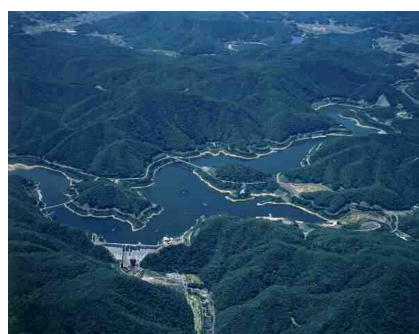
八田原ダム (H10.3完成)
