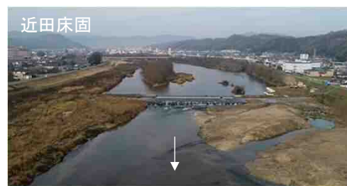
魚道のない横断構造物の例
