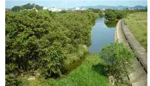
河道内樹木の繁茂状況
