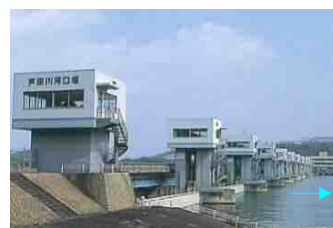
芦田川河口堰完成(S56.6完成)
