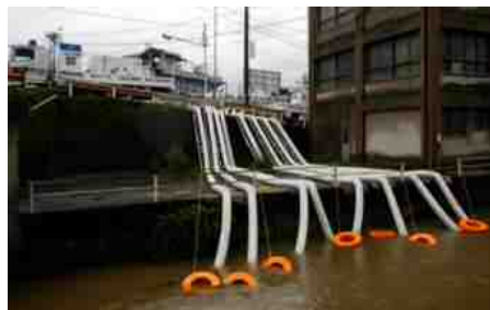
排水ポンプ車による排水活動
