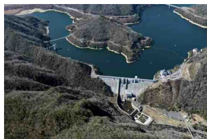
八田原ダム (H10完成)
