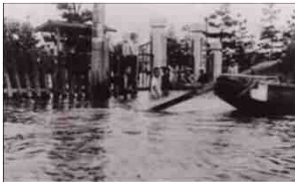
南小学校前の浸水状況
