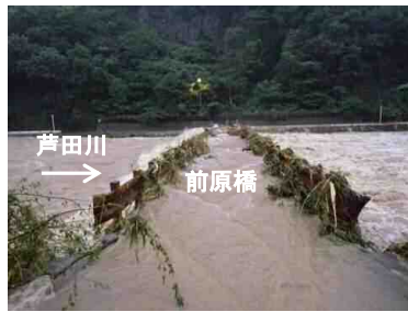
平成30年7月豪雨による出水状況 (前原橋)
