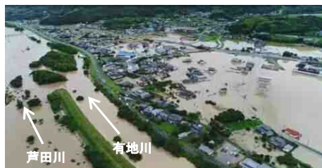
平成30年7月豪雨による浸水被害状況 (福山市駅家町上山守付近)
