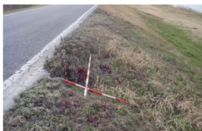
写真 2-3-1 堤防の陥没
