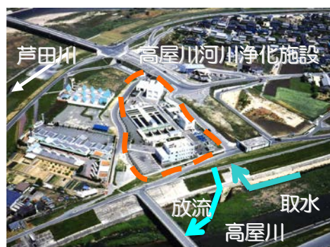
写真 5-1-9 高屋川河川浄化施設
