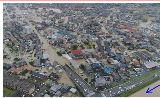
福山市山手町付近の浸水状況（内水）
