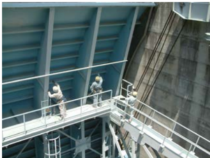
写真 5-2-16 クレストゲートの点検状況
