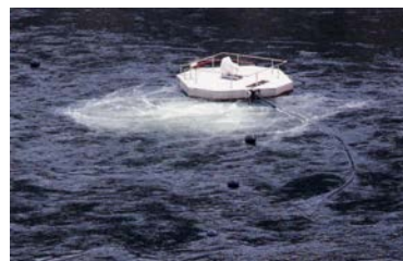
写真 5-1-12 躍層低下循環装
