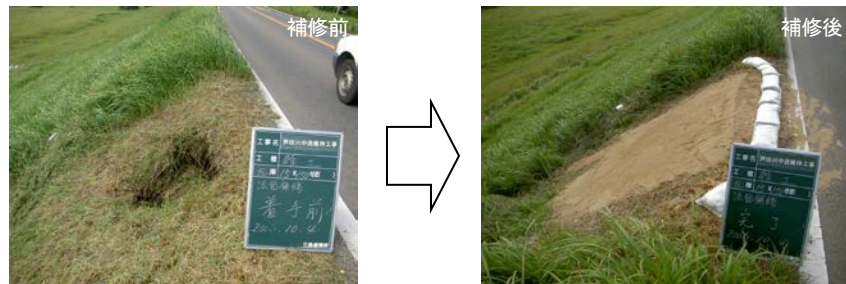
写真 5-2-8 堤防の補修状況
