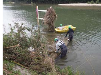
写真 5-2-15 塵芥除去作業状況
