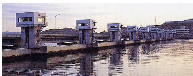
写真 2-2-2526 芦田川河口堰と河口大橋
