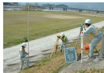
写真 5-2-4 縦横断測量
