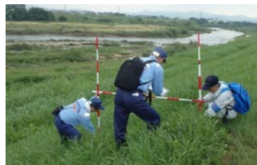
写真 5-2-2 堤防の点検状況
