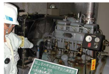
写真 5-2-3 排水ポンプ機場の点検状況
