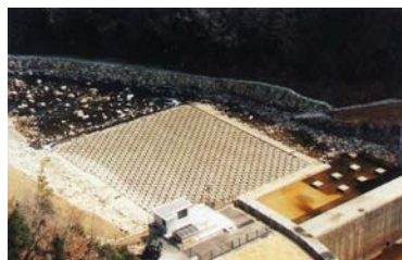
写真 5-1-13 礫間接触酸化施設
