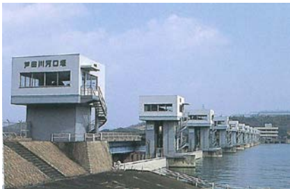
写真 1-2-3 芦田川河口堰（昭和 56 年 6 月完成）
