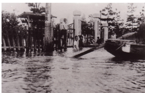
南小学校前の浸水状況
