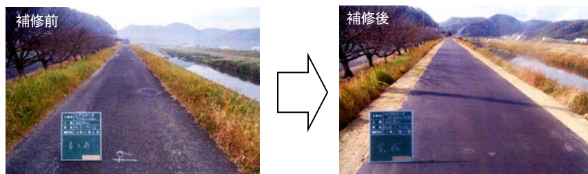
写真 5-2-9 堤防天端（上面）の補修状況
