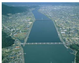
写真 2-2-2425 芦田川河口堰と湛水区間
