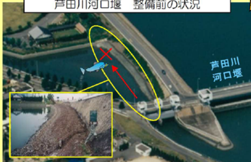
芦田川河口堰 整備前の状況
