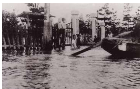
南小学校前の浸水状況
