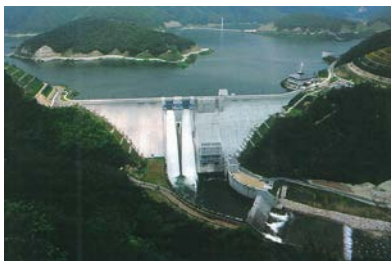
写真 1-2-4 八田原ダム (平成 10 年 3 月完成)
