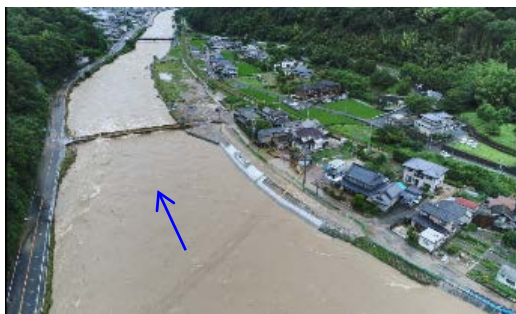
府中市父石町付近の浸水状況
