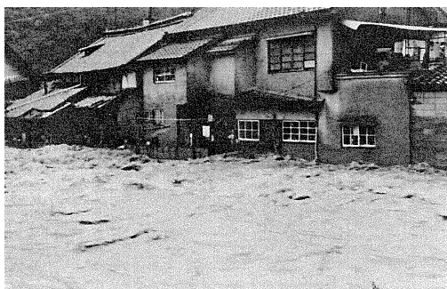
芦品郡新市町の浸水状況
