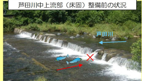
芦田川中上流部（床固）整備前の状況
