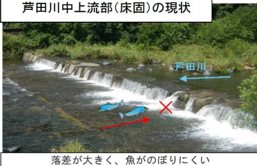
芦田川中上流部(床固)の現状
