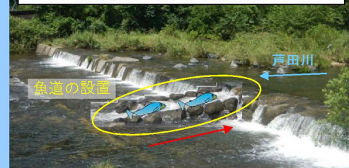
芦田川中上流部（床固）整備後のイメージ
