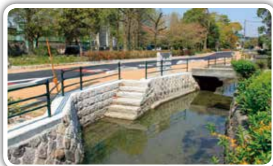
環境護岸（雁木・魚巢ブロック・水草樹）
