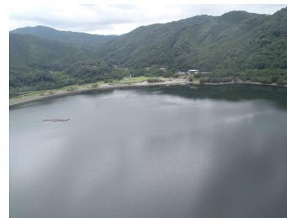
撤去後(平成30年)
