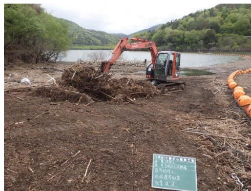
流木等の回収状況(H30.4.25撮影)
