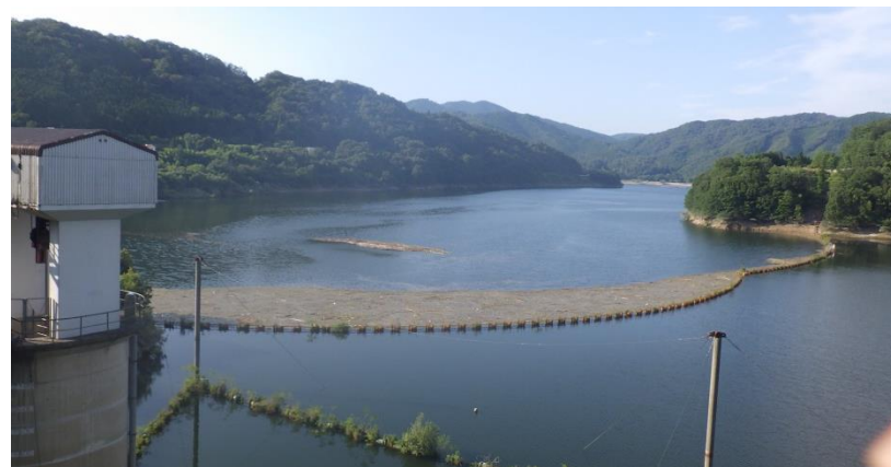
平成30年7月洪水後の流木等の状況(H30.7.27網場下流から撮影)
