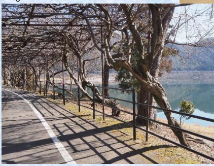
サイクリングロードに設置した転落防止柵 (フジの木を出来るだけ切らないように配慮)
