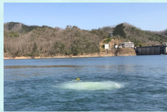
曝気設備の稼働状況
