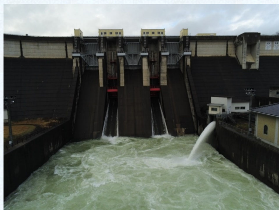
土師ダムフラッシュ放流の様子
