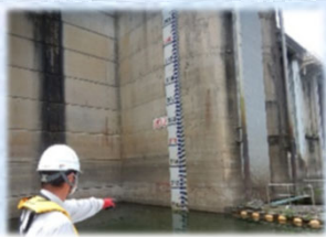
湖面からのダム点検
