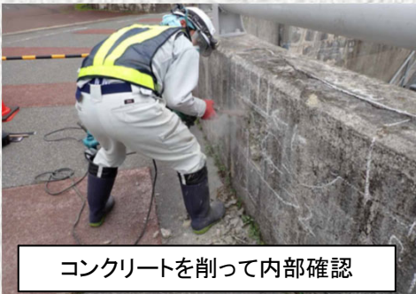
コンクリート内部の鉄筋探査
