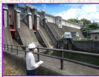
ダム下流広場から点検
