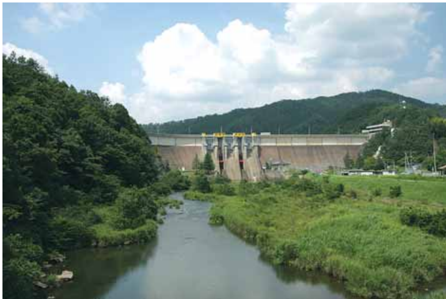
土師ダム堤体下流面全景
