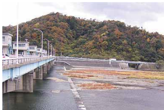
土師ダムから送られた水を取水する高瀬堰
