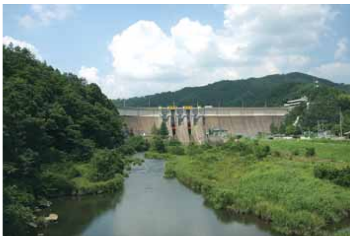
土師ダム全景（下流から）
