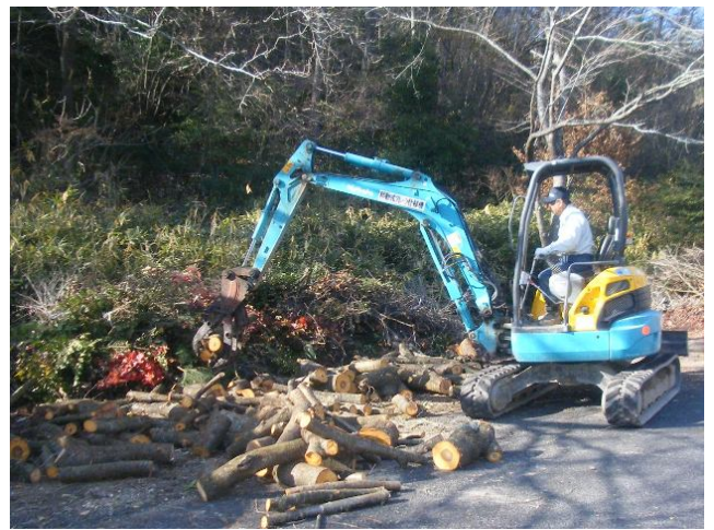
仕分班: 運搬された枝を種類毎に仕分けして、並べました。あまの量の多さのため、重機を使いました。
