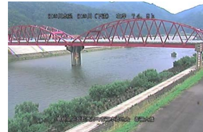
例: 高水敷の冠水
