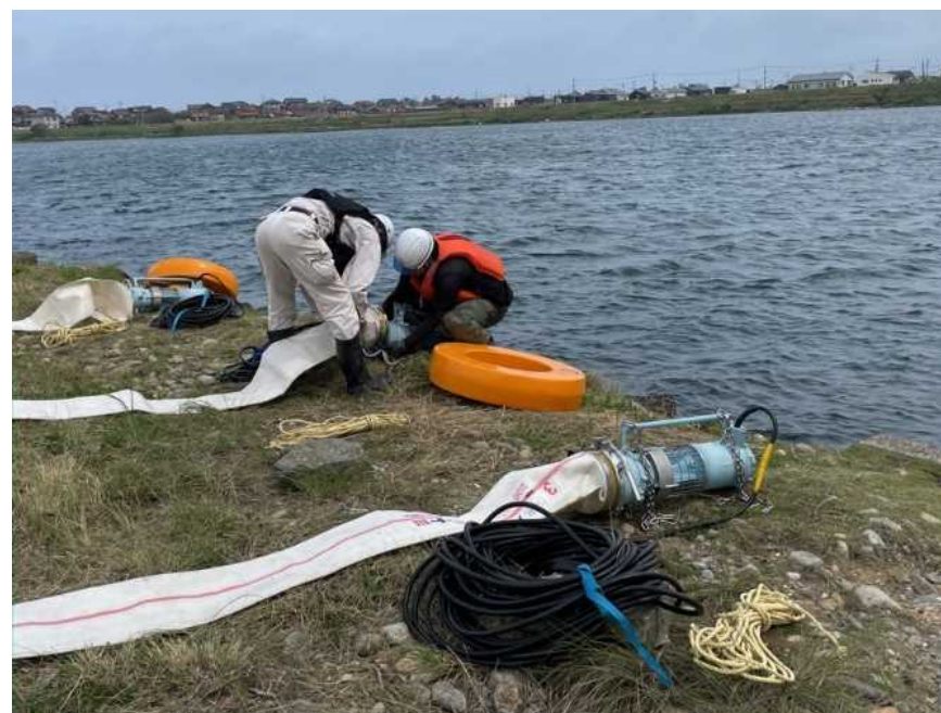
ポンプの吐口を設置する様子
