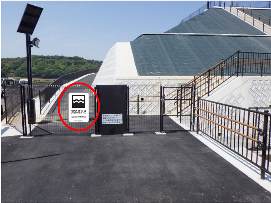
緊急避難場所の入口に設置する標識 (イメージ)
